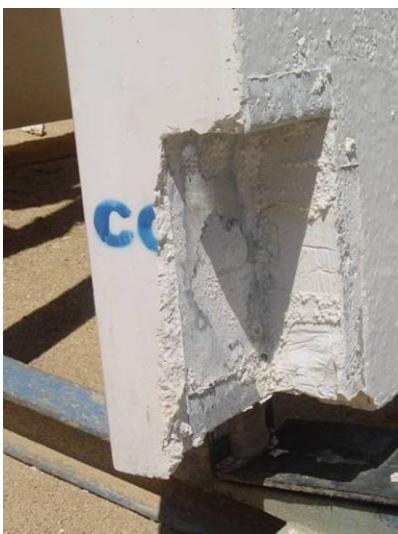
Fotografía 11: Cajeadado para apoyo del panel
