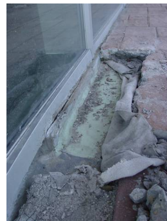
Fotografía 4: Encuentro fachada-pavimento exterior
