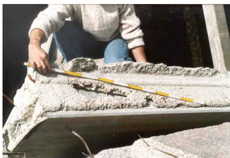
Fotografía 9: Hormigonado deficiente
