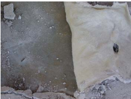
Fotografía 3: Membrana de la jardinera
