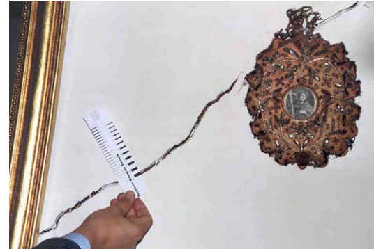
Fotografía 8: Fisuración en tabiques interiores de viviendas
