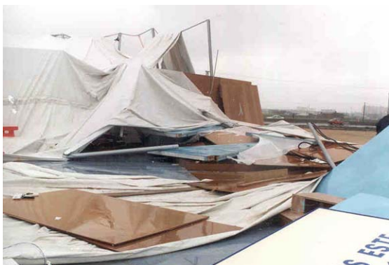
Fotografía 5: Colapso de una cubierta de lona, de carácter temporal
